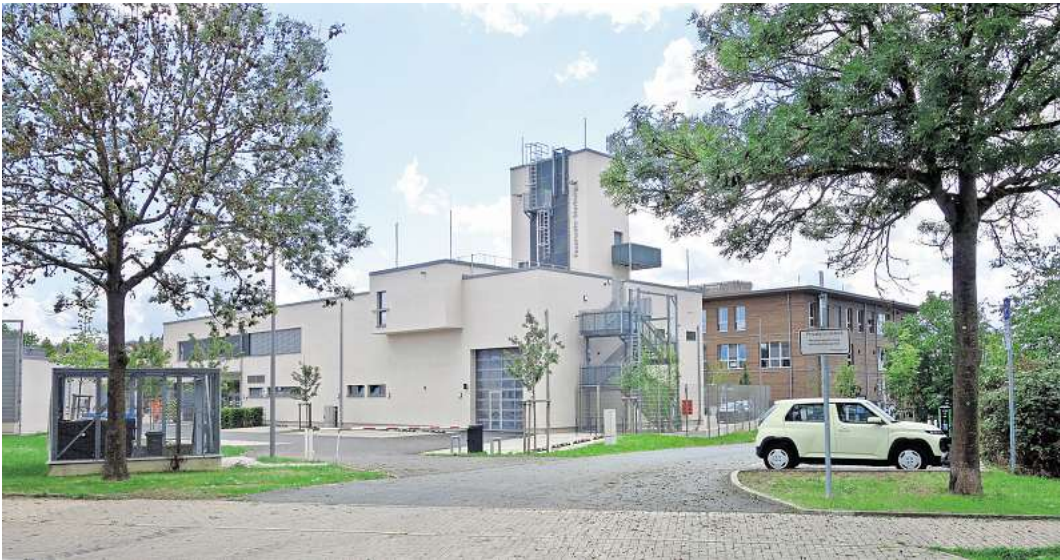
Zufahrtsweg zur Feuerwehr Cappel (bald Floriansweg)
