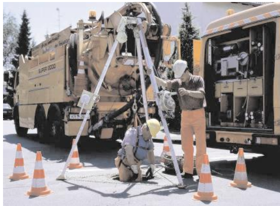
Bild 17: Rettung aus einem Schacht mittels Höhensicherungsgerät mit integrierter Rettungshubeinrichtung und transportabler Anschlagseinrichtung (Dreibein)
