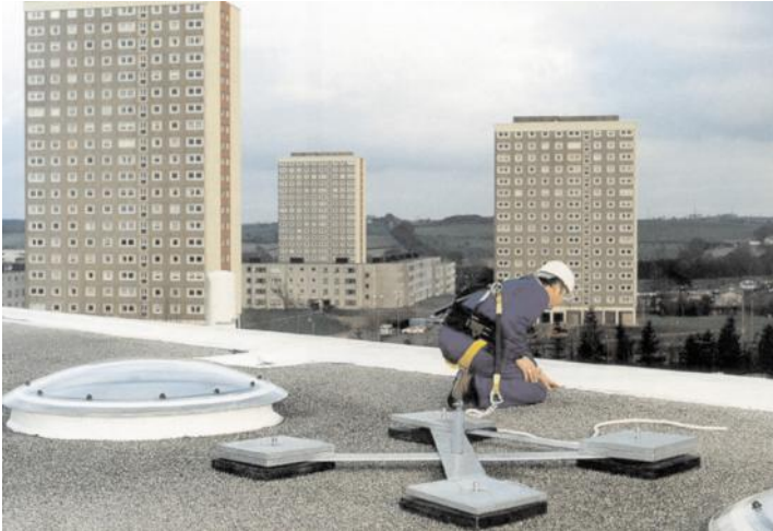
Bild 16: Durch Eigengewicht gehaltene Anschlagereinrichtung (z.B. Betongewichte)
