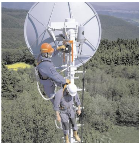
Bild 8: Abseilgerät mit integrierter Hubeinrichtung
