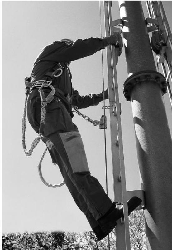
**Bild 16:** Beispiel einer Steigschutzeinrichtung mit Führung aus Stahldrahtseil
