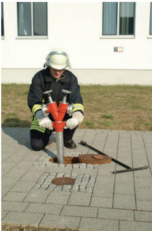
Zum Einsetzen des Standrohres wird der Deckel der Straßenkappe abgehoben. Festsitzende Deckel werden durch Schläge mit dem Unterflurhydrantenschlüssel gelockert.
