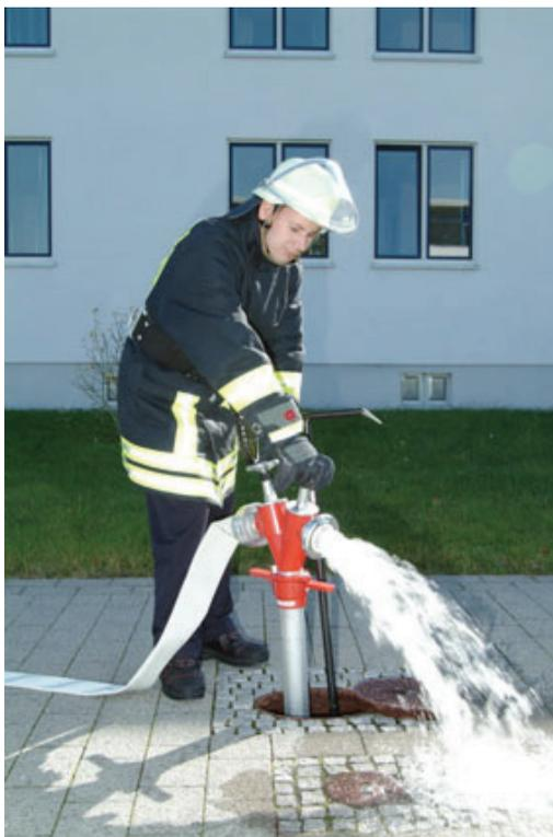
Ein Abgang am Standrohr wird geöffnet.
